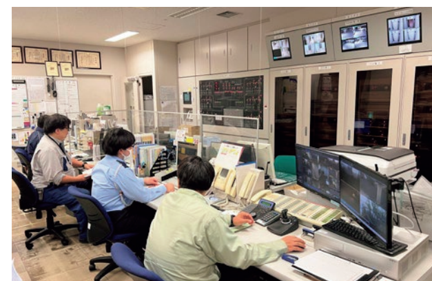
TOC有明防災センター
